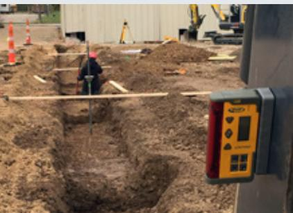
Le récepteur laser combiné CR700 de Spectra Precision® est un récepteur avec affichage pour les petits engins de terrassement et d'excavation. Il peut aussi se fixer sur une mire comme un récepteur laser classique et convient aussi parfaitement aux applications verticales pour le contrôle de l'alignement.
